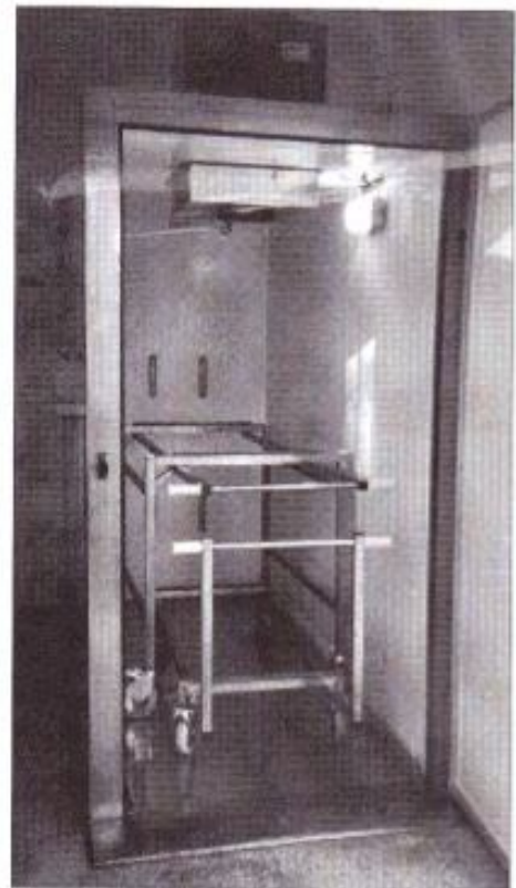
Komora chłodnicza w Goleniowie – system dwóch wózków niezależnych.
